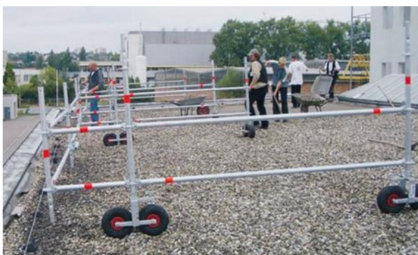
Rys. 2. Przykład tymczasowych barier.
